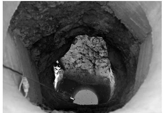
Εικ. 1. Η σήραγγα Σ1 και τα δύο στόμιά της προς τα ανατολικά και δυτικά, όπως φαίνονται από τη βόρεια πλευρά του στομίου του φρέατος Φ1.
