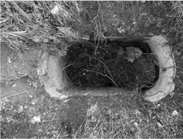
Εικ. 10. Η φρεατοειδής κατασκευή Φ11 στα νοτιοδυτικά της «Δωρικής Κρήνης» Κ1.
