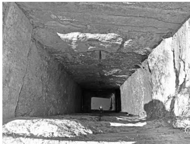
Εικ. 21. Το φρέαρ Φ17 στο νοτιοδυτικό άκρο της αγοράς.
