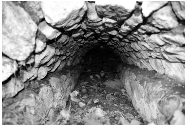
Εικ. 17. Το καταληκτήριο τμήμα του ρωμαϊκού υδραγωγείου Υ2 (Υ2γ) από τα νότια. Μπροστά το σωζόμενο με τη θόλο τμήμα του και στο βάθος το άνοιγμα της σήραγγας μετά το ενδιάμεσο κρημνισμένο μέρος.
