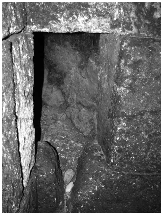
Εικ. 22. Η σήραγγα στη βόρεια πλευρά του φρέατος της αγοράς Φ17.
