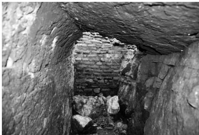
Εικ. 7. Η δυτική πλευρά του φρέατος Φ3 με χτισμένο το στόμιο της σήραγγας Σ2δ.
