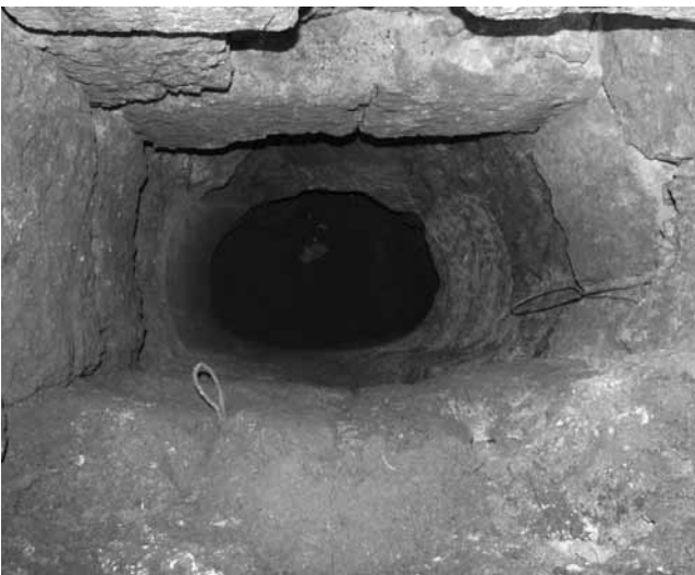
Εικ. 12. Το σημείο καμπής της σήραγγας κάτω από τη βόρεια πλευρά του σταδίου μέσα από το φρέαρ επίσκεψης.
