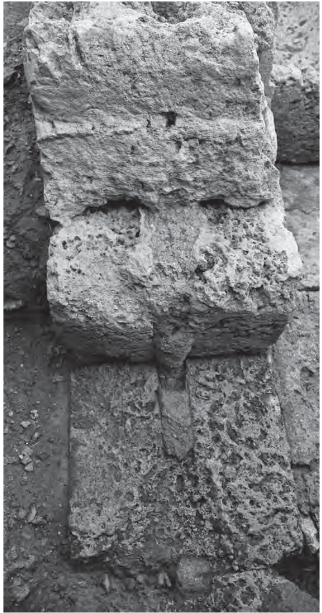
Εικ. 6. Σφράγιση των αρμών στα τοιχώματα της δεξαμενής κοντά στον βόρειο τοίχο.
